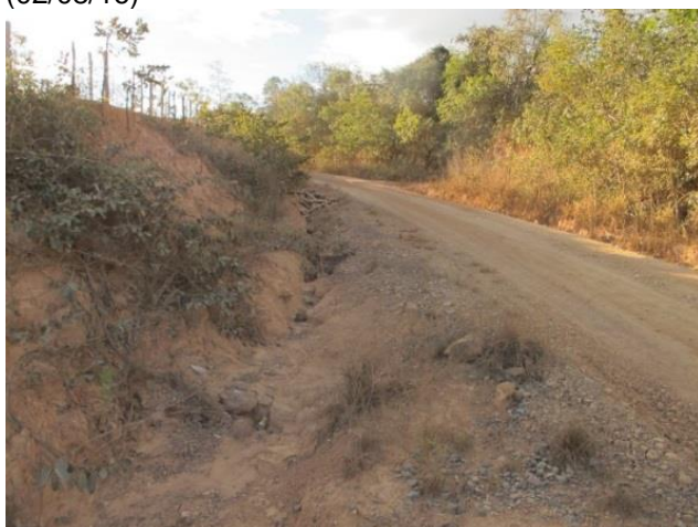
Foto 3: Escoamento a ser disciplinado com construção de lombada, bigode e barraginha. (02/08/16)
