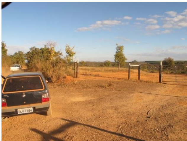
Foto 1: Local definido para construção bigode. (02/08/16)
