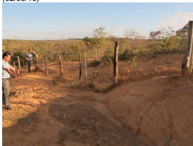
Foto 4: Local definido para construção de bigode interligado à barraginha. (02/08/16)
