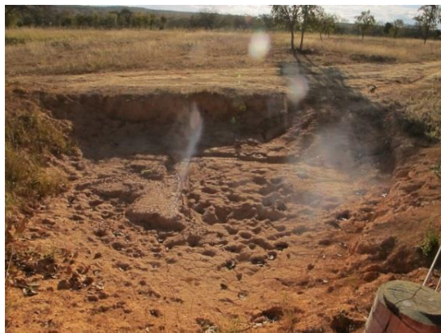
Foto 2: Local definido para construção barraginha. (02/08/16)
